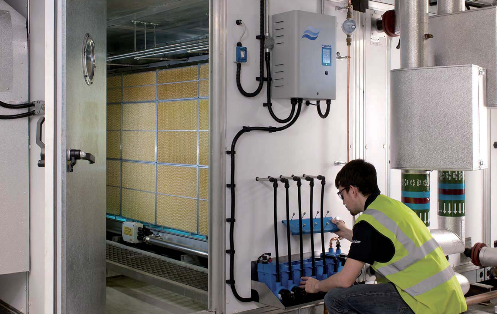
Установка Condair ME с наружным гидромодулем
